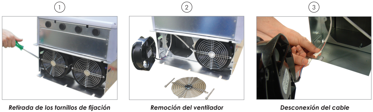
Figura 6.1 - Remoción del ventilador de los disipadores
