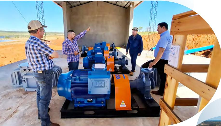
Para nuestro cliente **LANDCO SOCIEDAD ANÓNIMA**, suministramos e instalamos 8 transformadores WEG, junto con 8 bombas de alto caudal SAER equipadas con motores WEG. Además, implementamos 8 tableros de mando para el control de los motores y llevamos a cabo la instalación y conexión de todos los equipos, garantizando un sistema eficiente y confiable.
